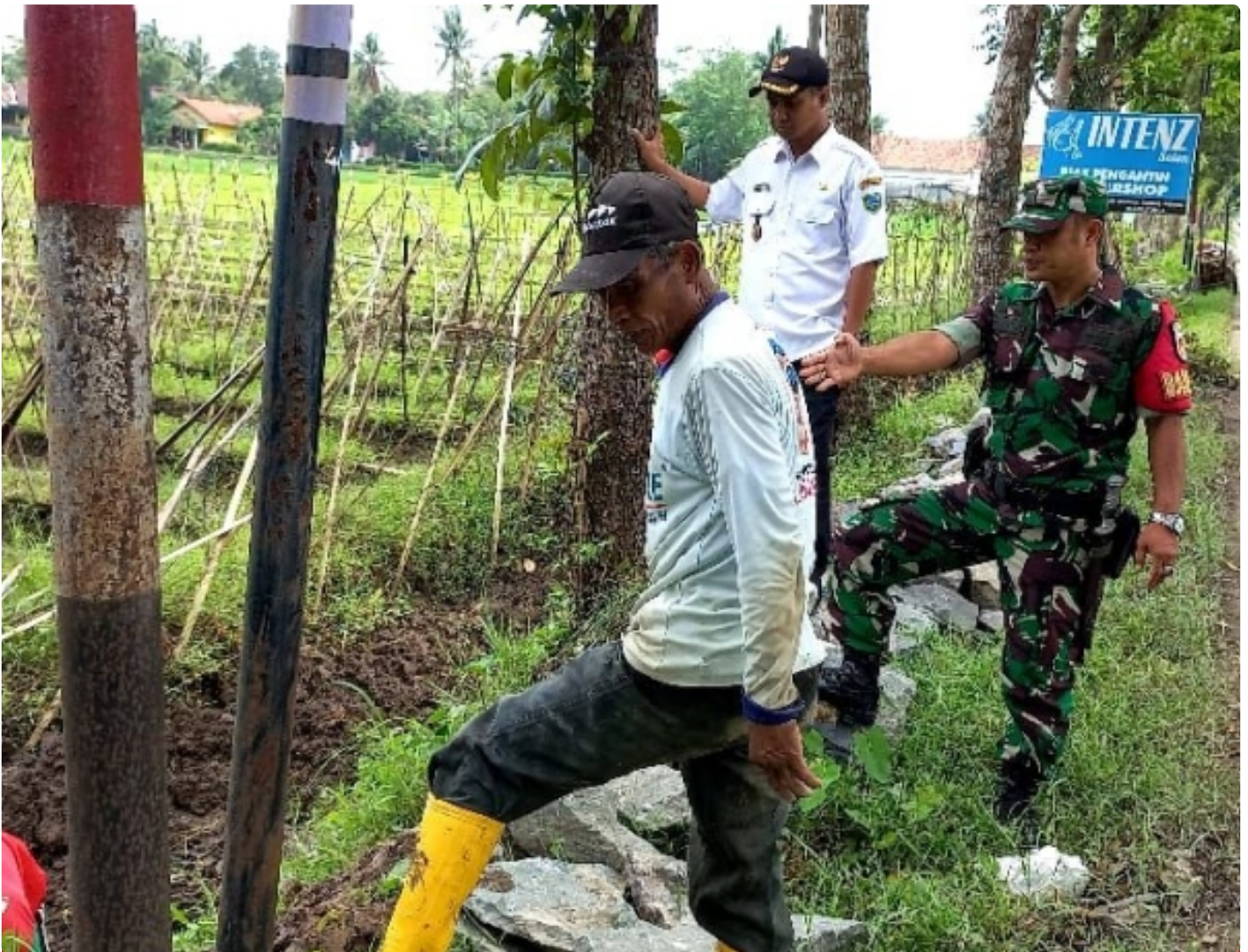
Babinsa Koramil 19/Kuwarasan Serda Jumadi dan Kades Kalipurwo Yuli Stianto melaksanakan pemantauan pembangunan talud jalan di dukuh Kalideres
